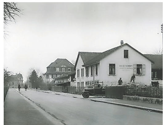
Der Werkhof des Baugeschäfts de Capitani wurde 1921 an einsamer Lage erstellt.
